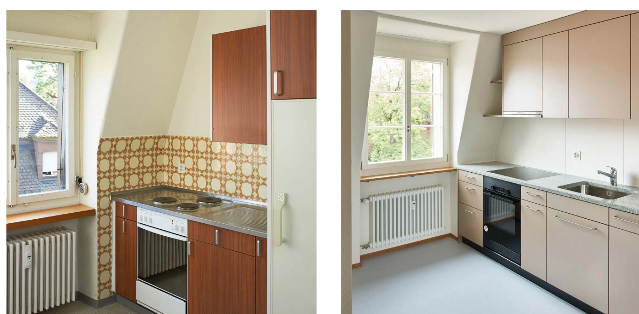
Beispiel Instandsetzung Letten 4, Küche vorher – nachher: günstige, beständige Lösungen
